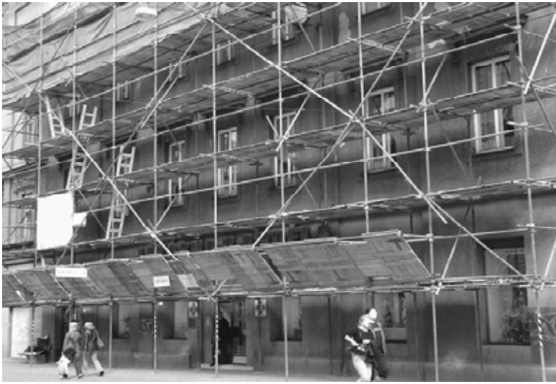
Hình 5.36. Hệ thống giằng chéo và ván gỗ chắn vật rơi của hệ giàn giáo
