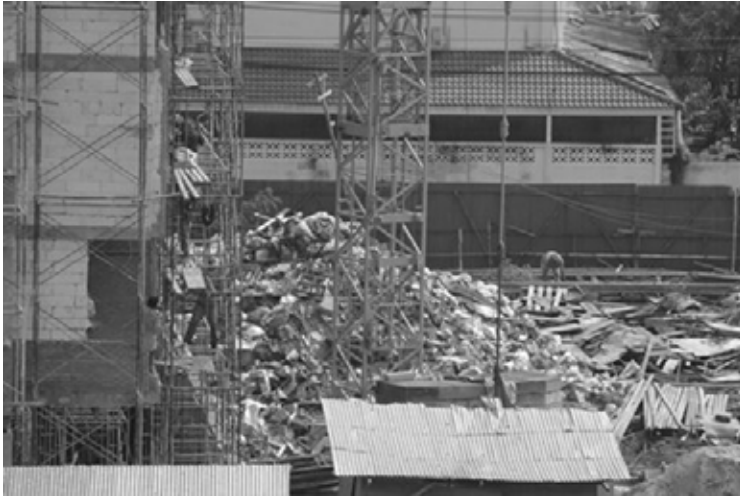
Hình 7.2. Công trường có nhiều đất, gỗ vụn phế liệu
