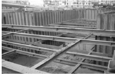
Hình 3.19. Thi công tường vây tầng hầm sử dụng cừ larsen và hệ văng chống
