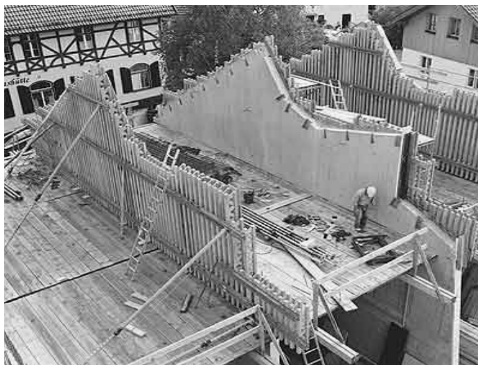
Hình 3.38. Hệ cốp pha tường
