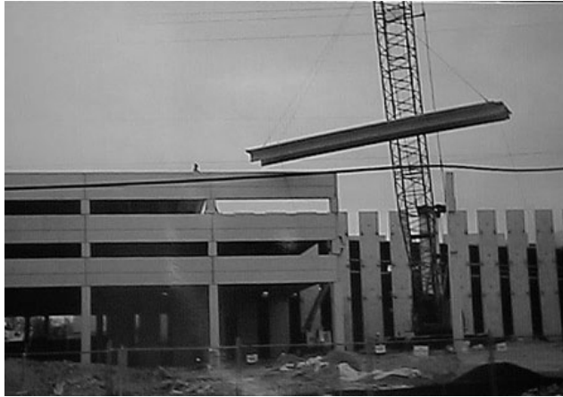
Hình 3.43. Cần trục cầu lắp tấm panen vào vị trí thiết kế.
