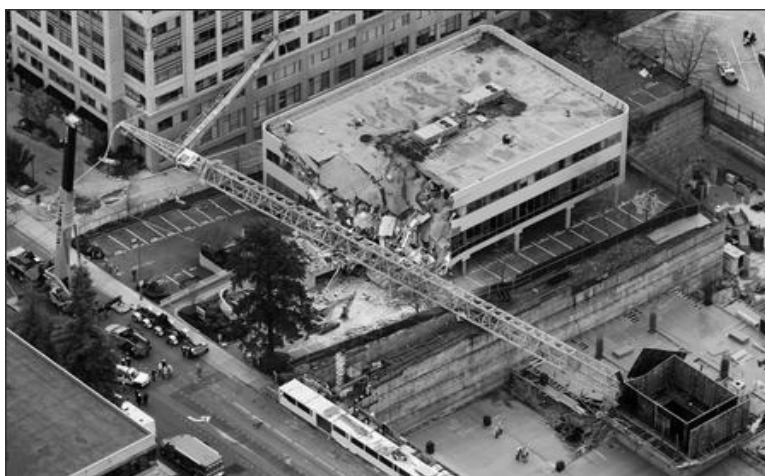
Hình 4.27. Bulông liên kết phân thân cần trục với móng bị hỏng gây đổ cần trục
