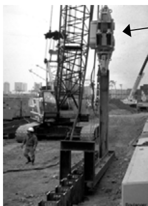
Hình 3.21. Ép các thanh thép hình chữ I sử dụng máy ép rung
