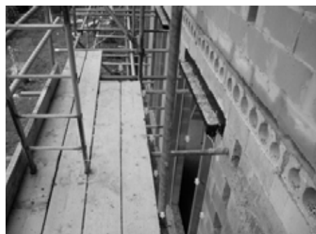
Hình 5.16. Sàn công tác cách quá xa công trình và chân giáo đặt vào khe hở của sàn
