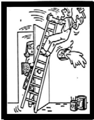
Hình 5.7. Trèo thang và làm việc trên thang không đúng yêu cầu về an toàn
