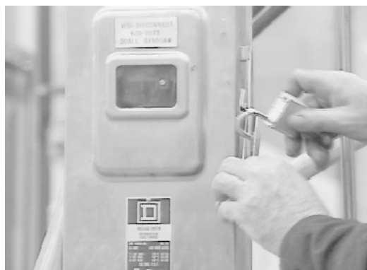
Hình 4.19. Thực hiện khóa máy khi không sử dụng
