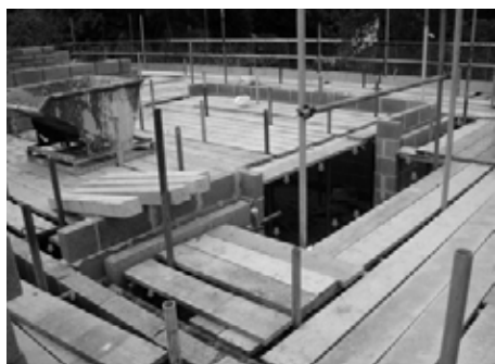
Hình 5.15. Sàn công tác có nhiều khe và lỗ rộng
