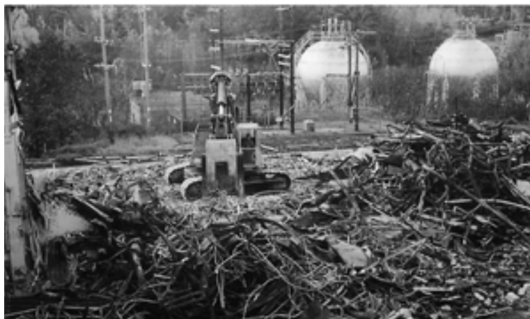
Hình 3.4. Sản phẩm sau khi phá, dỡ với nhiều thanh thép phế liệu
