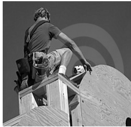
Hình 5.1. Nguy cơ bị trượt ngã vì không có dây an toàn
