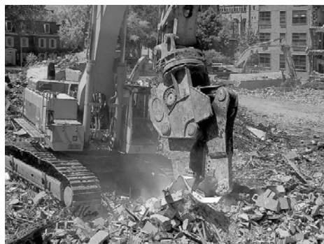
b) Lưỡi gắp được lắp vào đầu cần máy xúc
