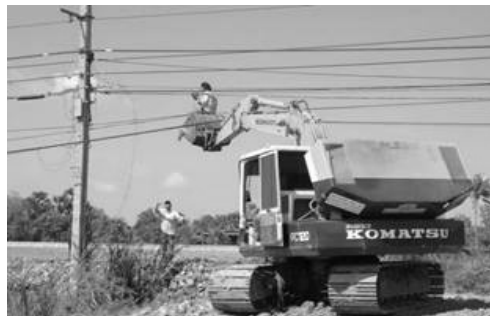
Hình 4.21. Tuyệt đối cấm đứng trên gầu của máy xúc
