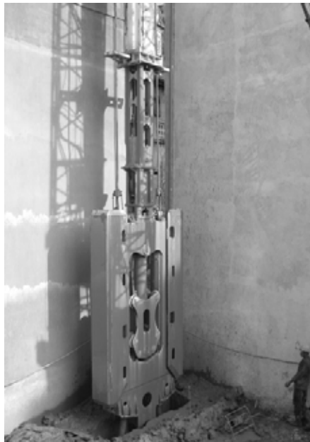
Hình 3.16. Lỗ cọc barrette đang được đào
