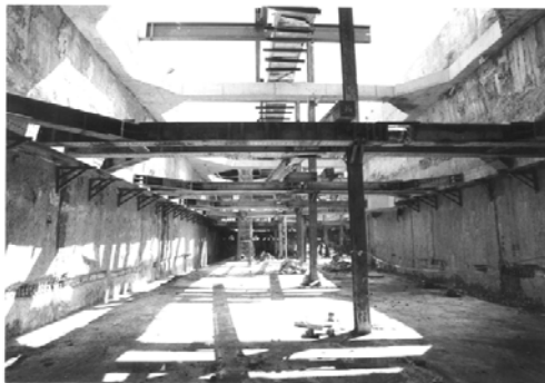
b) Giữ ổn định tường vây sử dụng thép hình
