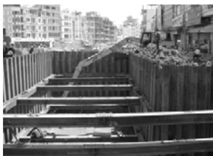
Hình 3.23. Đào đất tầng hầm sử dụng máy xúc gầu nghịch
