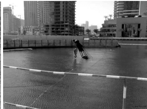
c) Quang cảnh tầng hầm bị nước tràn đầy
