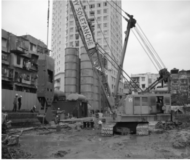
Hình 3.17. Công trường thi công cọc barrette
