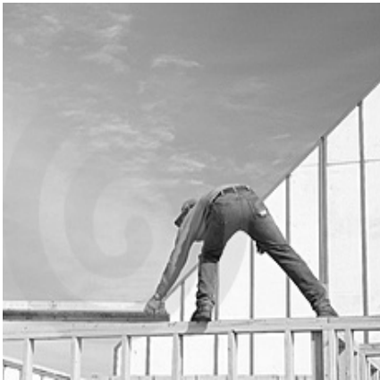
Hình 5.1. Nguy cơ bị trượt ngã vì không có dây an toàn
