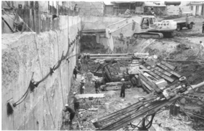
a) Thi công hệ thống neo tường bê tông cốt thép
