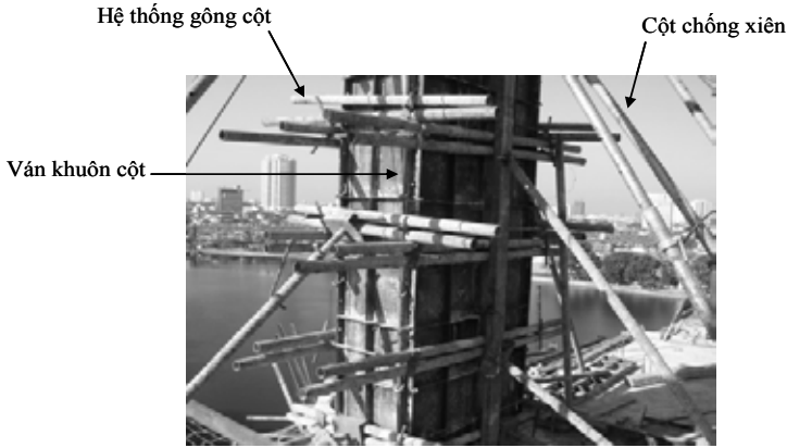
Hình 3.36. Hệ cốp pha cột
