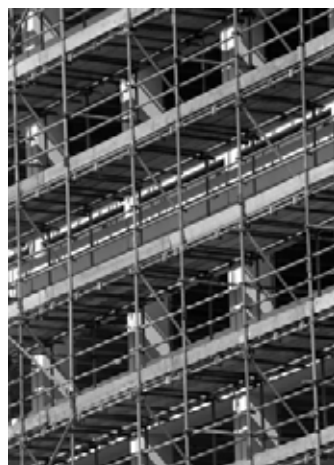
Hình 5.37. Hệ thống lan can và các tấm gỗ chắn vật rơi của hệ giàn giáo
