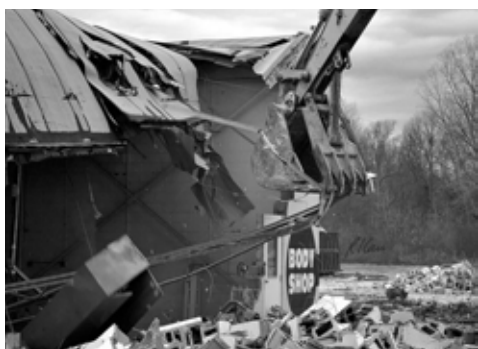
a) Đẩy đổ tường công trình
