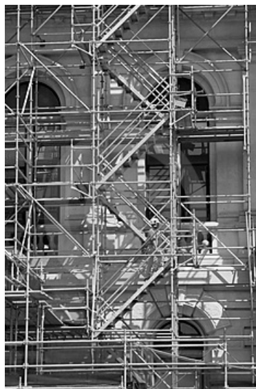
Hình 5.38. Cầu thang tạm giữa các tầng giáo
