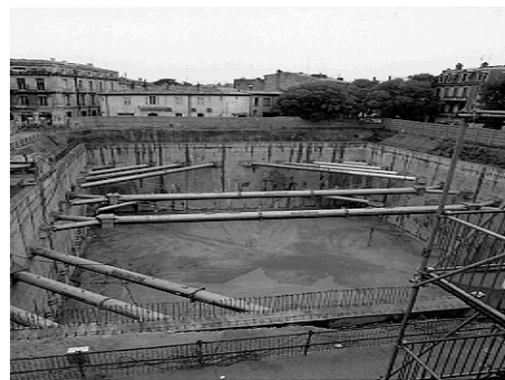
b) Giữ ổn định tường vây sử dụng thép ống
