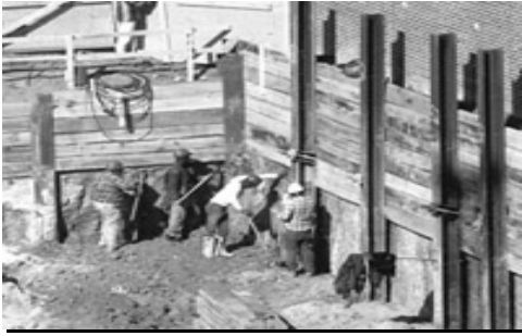
Hình 3.18. Thi công tường vây tầng hầm sử dụng thép chữ I và ván gỗ
