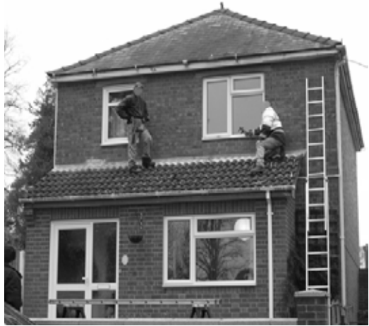
Hình 5.1. Nguy cơ bị trượt ngã vì không có dây an toàn
