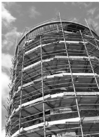
Hình 5.37. Hệ thống lan can và các tấm gỗ chắn vật rơi của hệ giàn giáo
