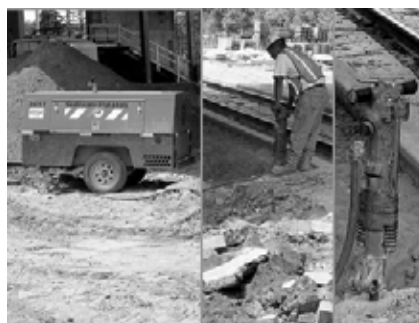
b) Máy phá bê tông thủ công
