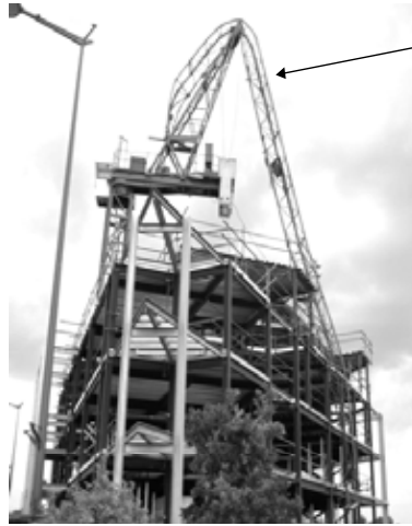
Hình 4.6. Cần trục tháp bị gãy tay cần sau cơn bão
