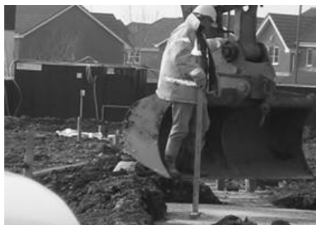
Hình 4.21. Tuyệt đối cấm đứng trên gầu của máy xúc
