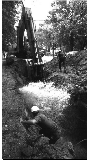
Hình 3.29. Máy xúc đào phải đường ống nước
