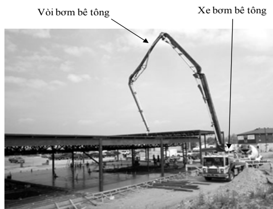
Hình 3.41. Đổ bê tông sử dụng xe bơm bê tông
