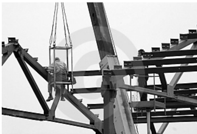
Hình 3.47. Sử dụng nôi treo khi lắp ghép kết cấu thép
